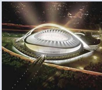
Obras de construcción del Estadio Moses Mabhida de Durban para la Copa del Mundo de la FIFA de Sudáfrica 2010. El Centro de Arbitraje y Mediación de la OMPI ya ha administrado casos relacionados con la Copa del Mundo de 2010.
