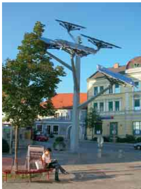
Un arbre photovoltaïque à Gleisdorf (Allemagne).
