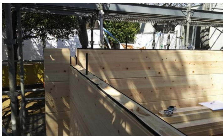
CLT ログハウスのログ材を交互に積む様子
