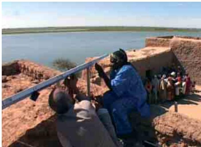
Installation de panneaux solaires dans le village de Dejegalia (Éthiopie)
